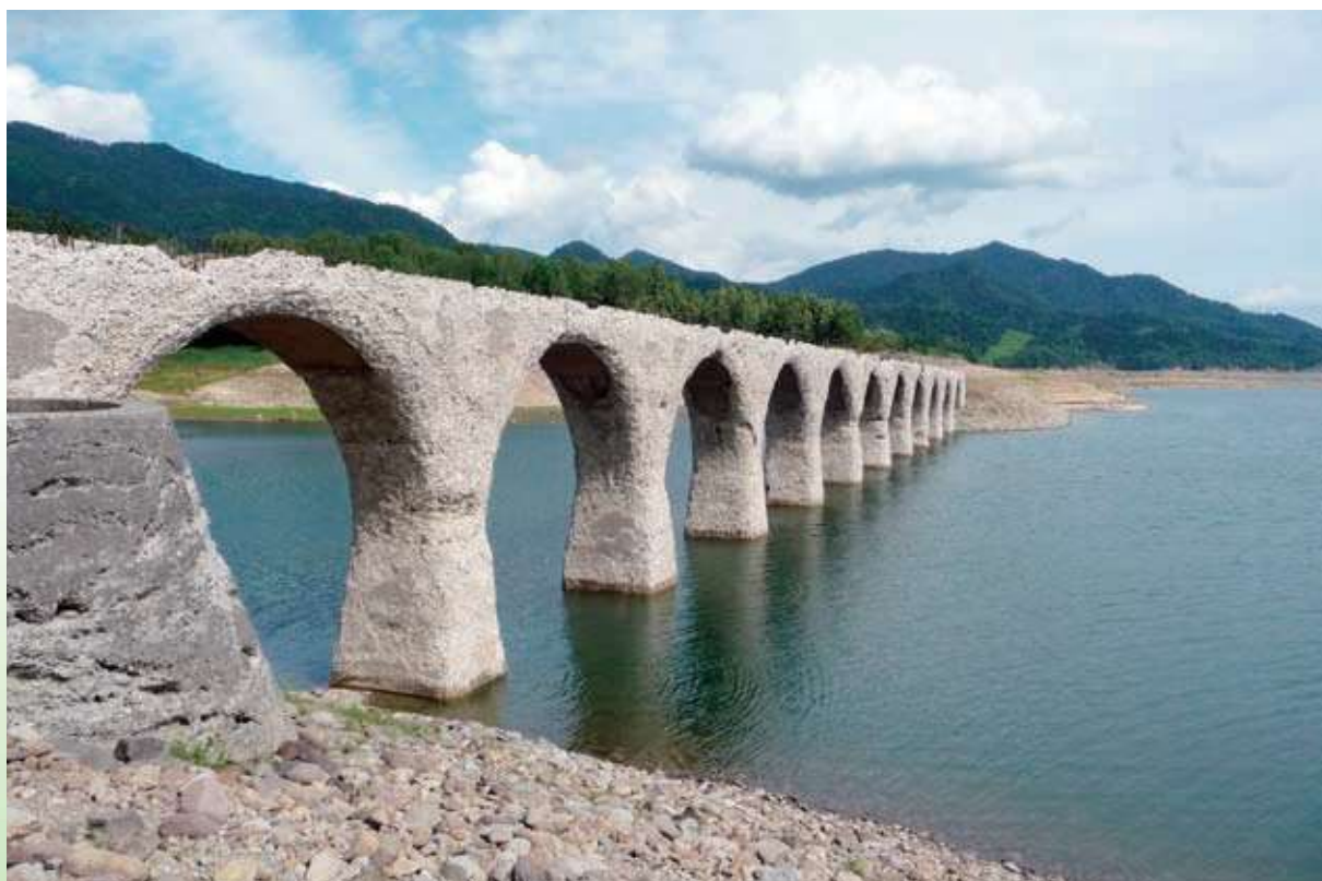
旧国鉄土幌線タウシュベツ川橋梁(北海道河東郡上士幌町)
